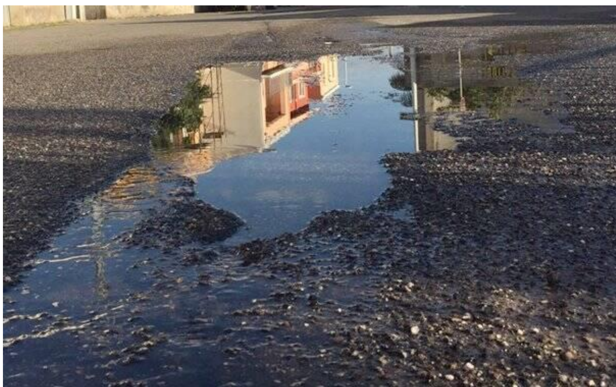
Una perdita d'acqua per strada
